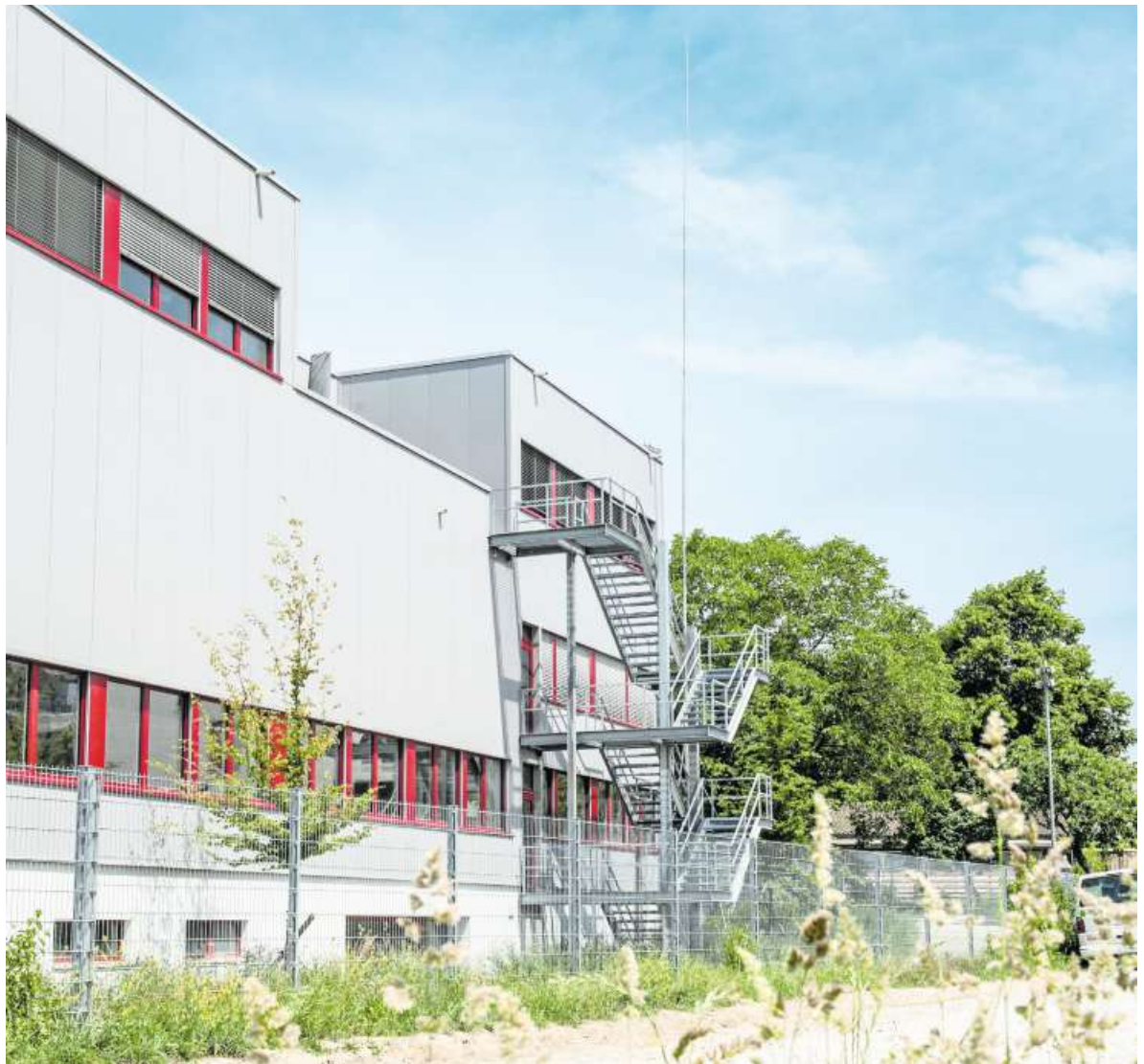
Das Baugesuch steht bereit. Hier will Salt eine neue 5G-Antenne hinstellen.
